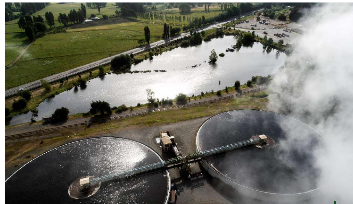
Planta Santa Fe, Región del BioBío. Junto con buscar la eficiencia en nuestros procesos, buscamos tener una producción sustentable. Actualmente existen proyectos para reducir el uso de agua en esta planta, contribuyendo así a la meta corporativa de CMIPC de reducción de agua al 2025.
